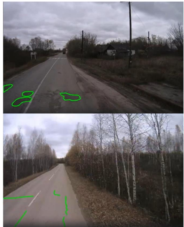
Рисунок 4. Пример работы YOLOv3 в задаче детектирования трещин и дорожных заплаток на асфальте
