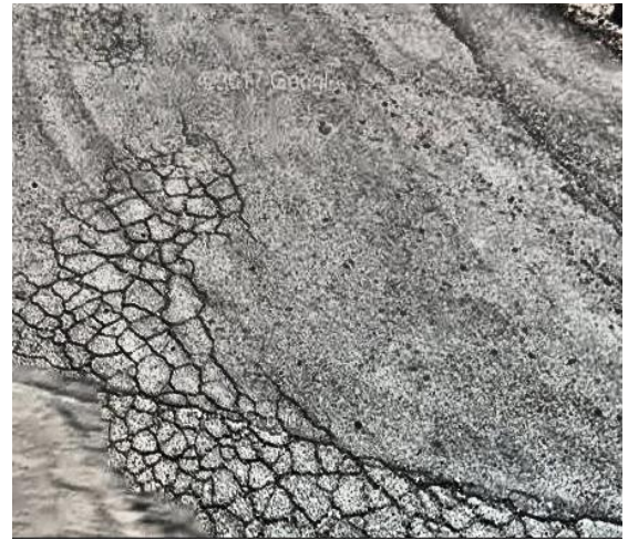
Рис. 4. Пример кадра с объектом класса mosaic-crack
